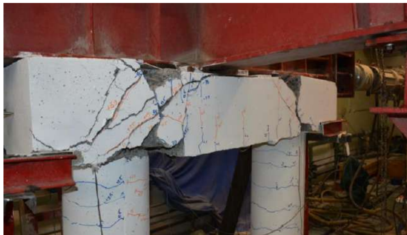
Fig. 27. Failure mode of SP-80
